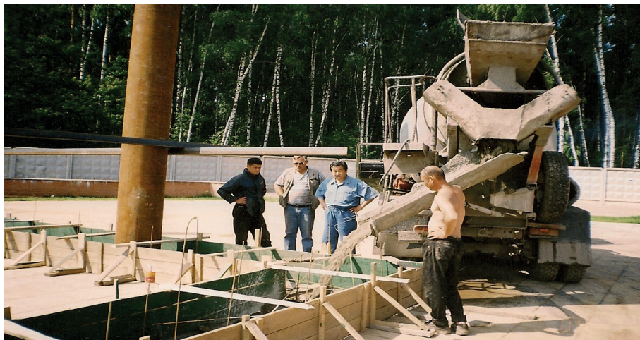
2004 г. Строительство зала гражданской панихиды
