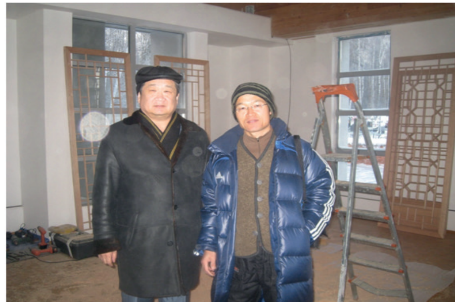
2010 г. Монтаж корейских решеток
