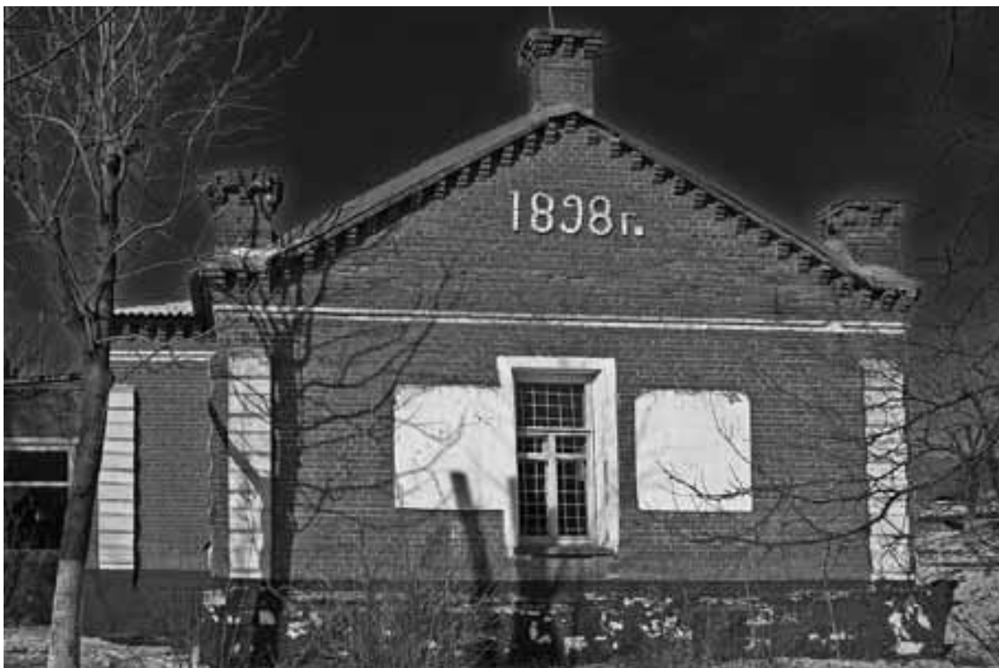
Раздольное, воинское здание постройки 1898 г.
