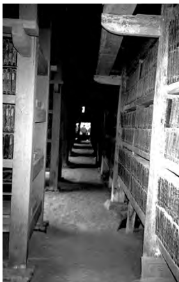
Буддийский монастырь Хэинса (пров. Южная Кёнсан), хранилище 81 137 деревянных ксилографических досок с буддийскими каноническими текстами «Пэальман тэчжангён». Время создания досок — 1236–1251 гг. (Национальное достояние Республики Корея № 32)
