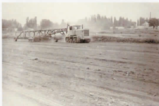
Рис. 34. Выравнивание полей сельхозорудием в виде лестницы
